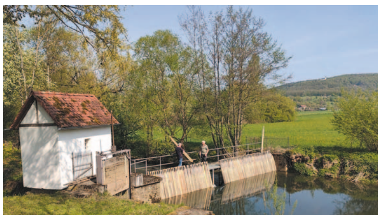
Ein Nadelwehr bei Kirchehrenbach staut die Wiesent zur Wässerung der „Mühl- und Auerbergwiesen“ Foto: Roland Lindacher
