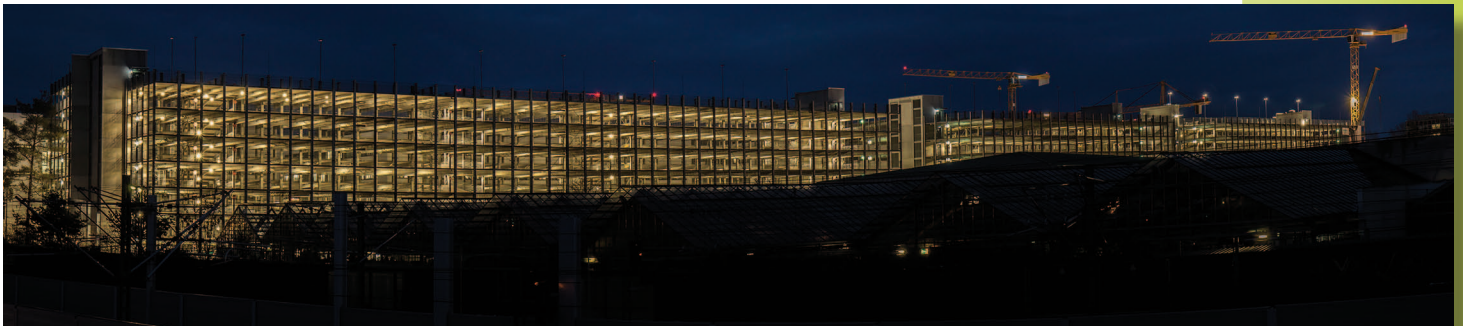
Erlangens größtes sakrales Gebäude - hier werden Autos angebetet!
