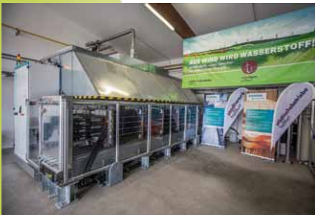
und Elektrolyseur des Stadtwerks Haßfurt
